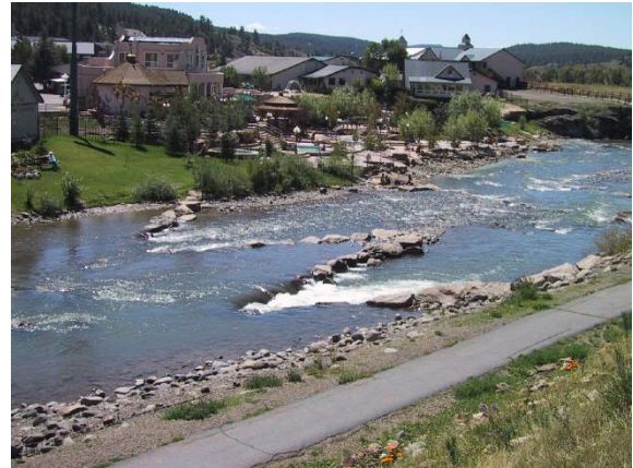
شکل ۱. سازه w-weir و شماتیک آن
