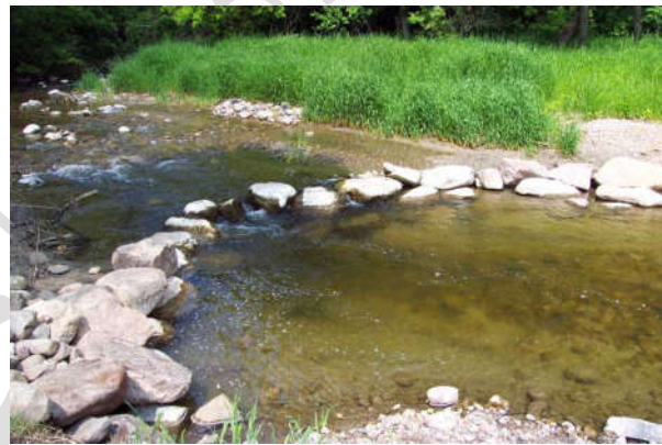
شکل ۲. سازه cross vane و شماتیک آن
