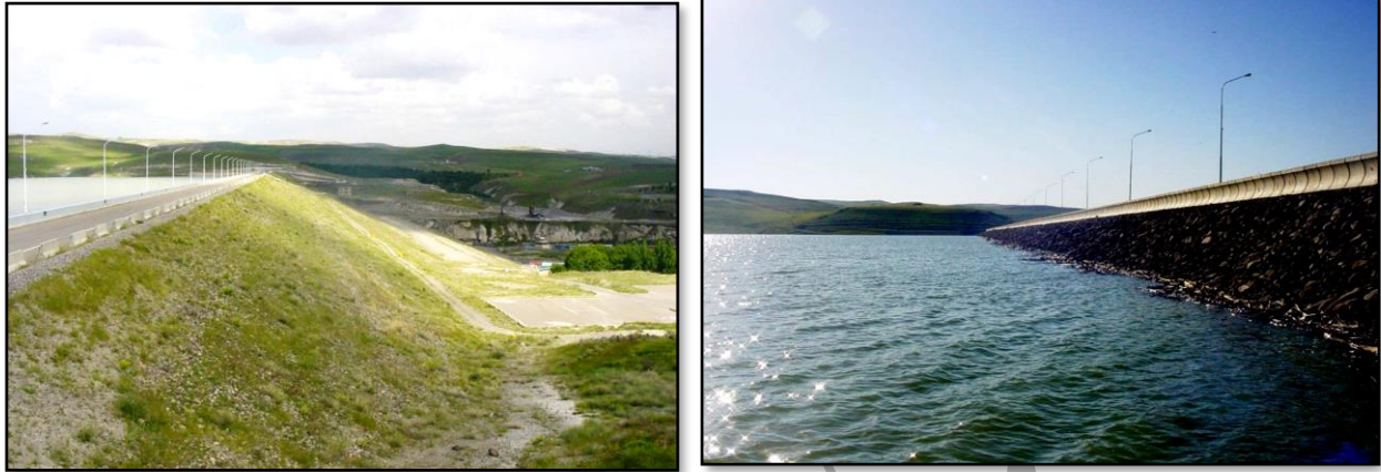
شکل ۲- نمایی از شیب بالا و پایین دست سد خاکی علویان
