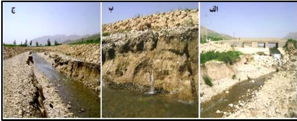
شکل ۲. نمایی از وضعیت موجود رودخانه خشکه رود فارسان: الف) پل عیسی آباد، ب) پدیده تراوش آب و ج) رسوبات حساس به فرسایش
