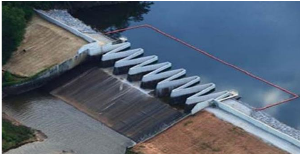
شکل ۳. نمونه‌ای از سرریز کنگره‌ای
