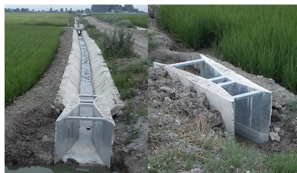
شکل ۷. نصب پارشال فلوم در ورودی کانال‌های بتنی و خاکی
